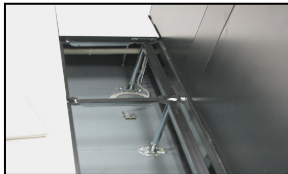
Suprafata pardoselii a fost vopsita cu vopsea epoxidica, antistatica.
